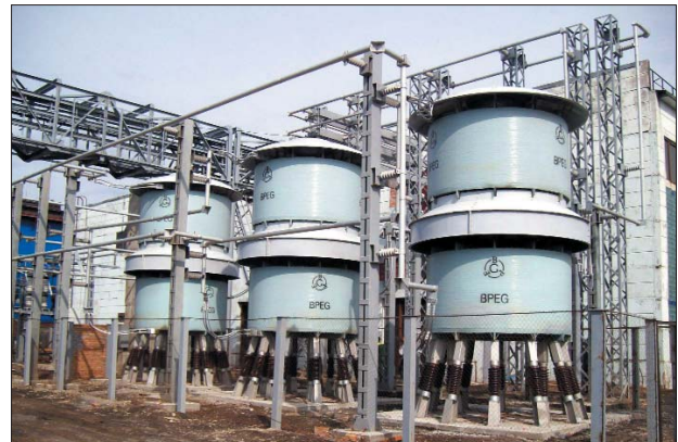
Компенсирующие реакторы ТРП
